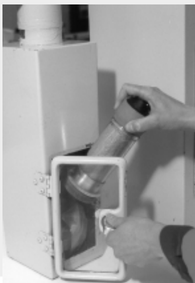
Контейнер приходит в лабораторию по пневмотрубе
